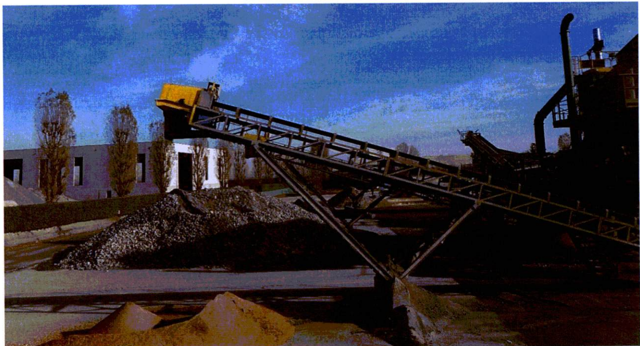
Figura 4-2 – Impianto di trattamento
