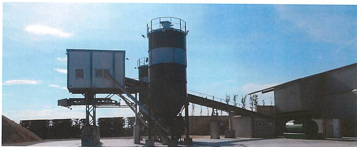
Figura 5 - Linea di produzione di calcestruzzo
