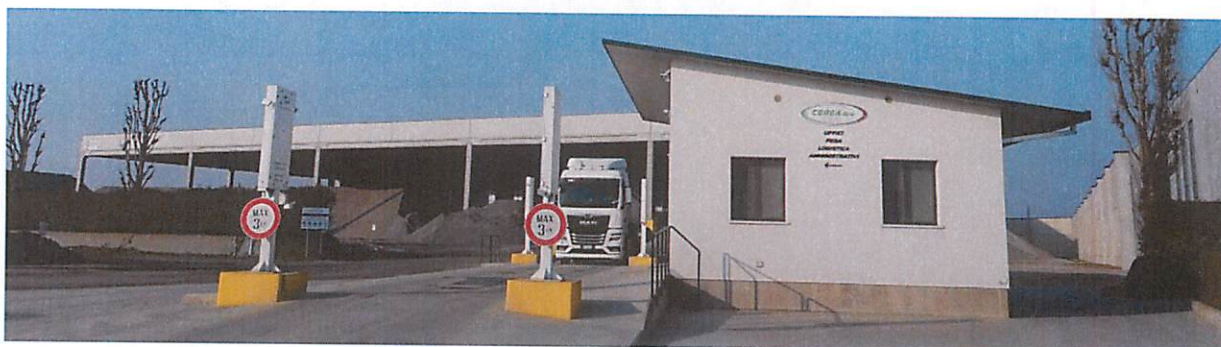
Figura 15 - Portali di controllo radiometrico sulla pesa
