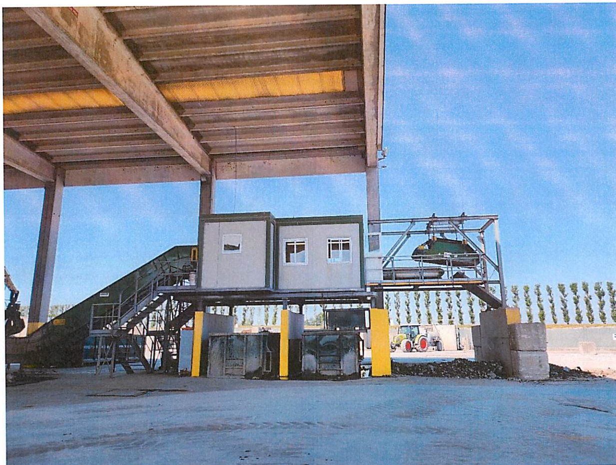
Figura 5-1 – Impianto di cernita manuale
