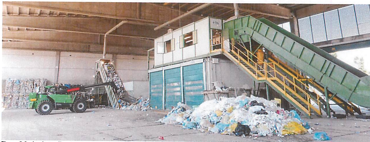
Figura 5-3 - impianto di recupero carta e plastica
