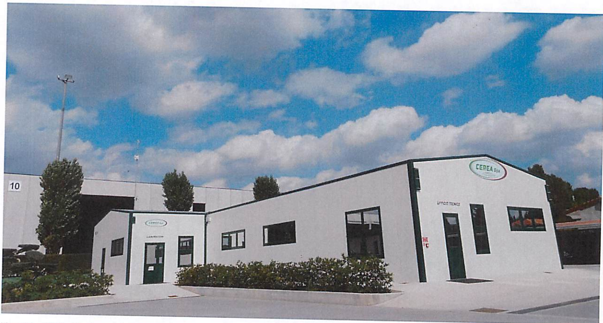
Figura 8 - Ufficio Tecnico e Laboratorio
