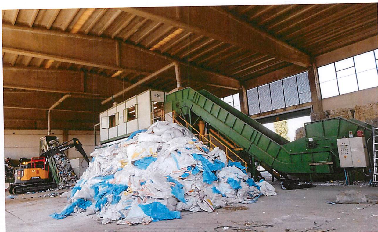
Figura 5-2 - impianto di recupero carta e plastica
