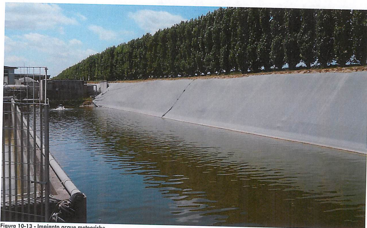
Figura 10-13 - Impianto acque meteoriche
