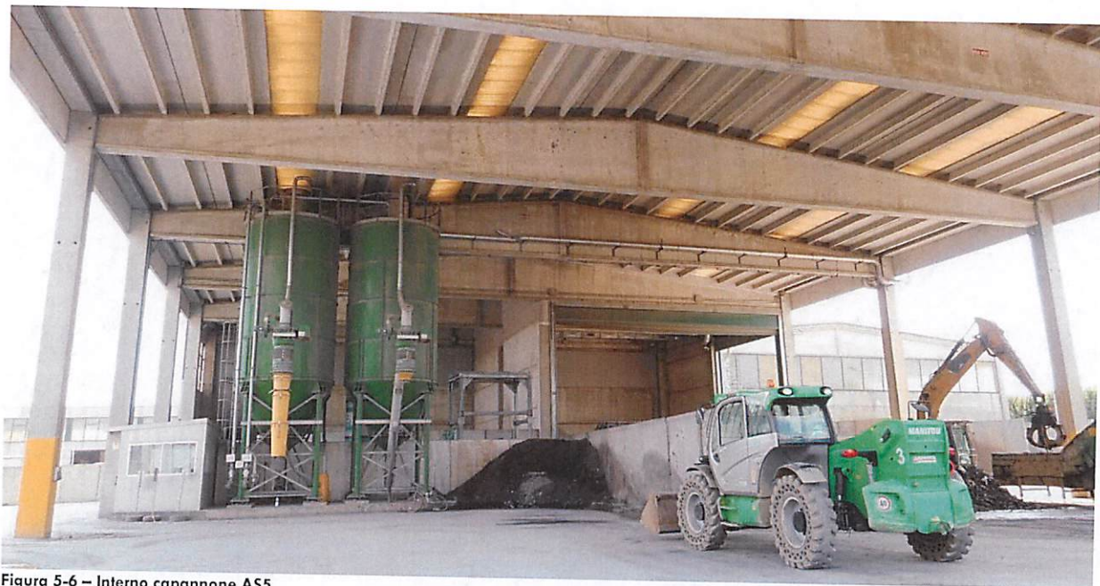
Figura 5-6 – Interno capannone AS5
