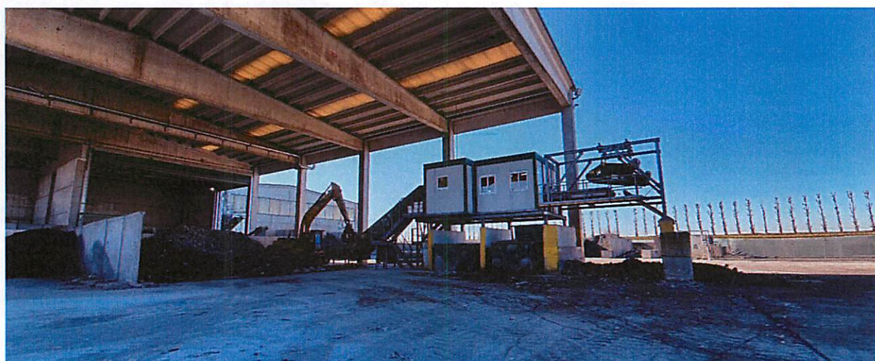
Figura 5-5 - Interno capannone con impianto cernita manuale – fine 2021
