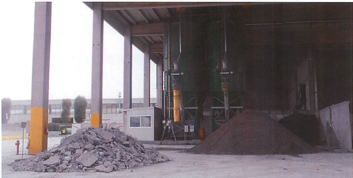
Figura 5-6 – Interno capannone AS5
