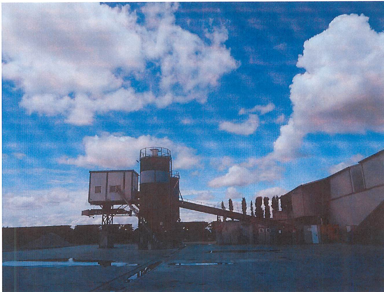
Figura 5-4 - Linea di produzione di calcestruzzo
