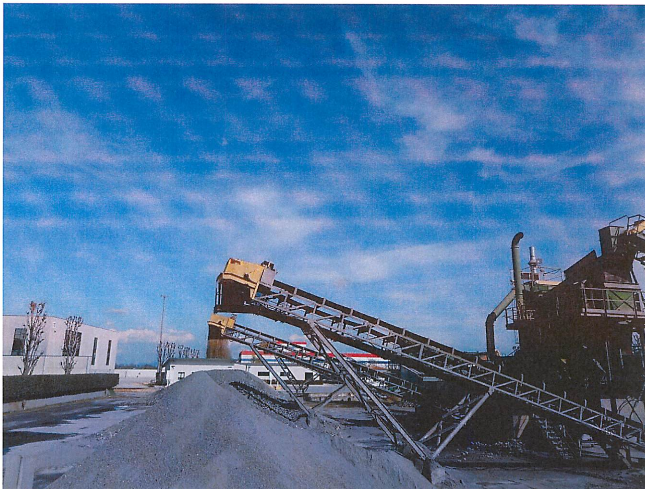
Figura 5-1 – Impianto di trattamento
