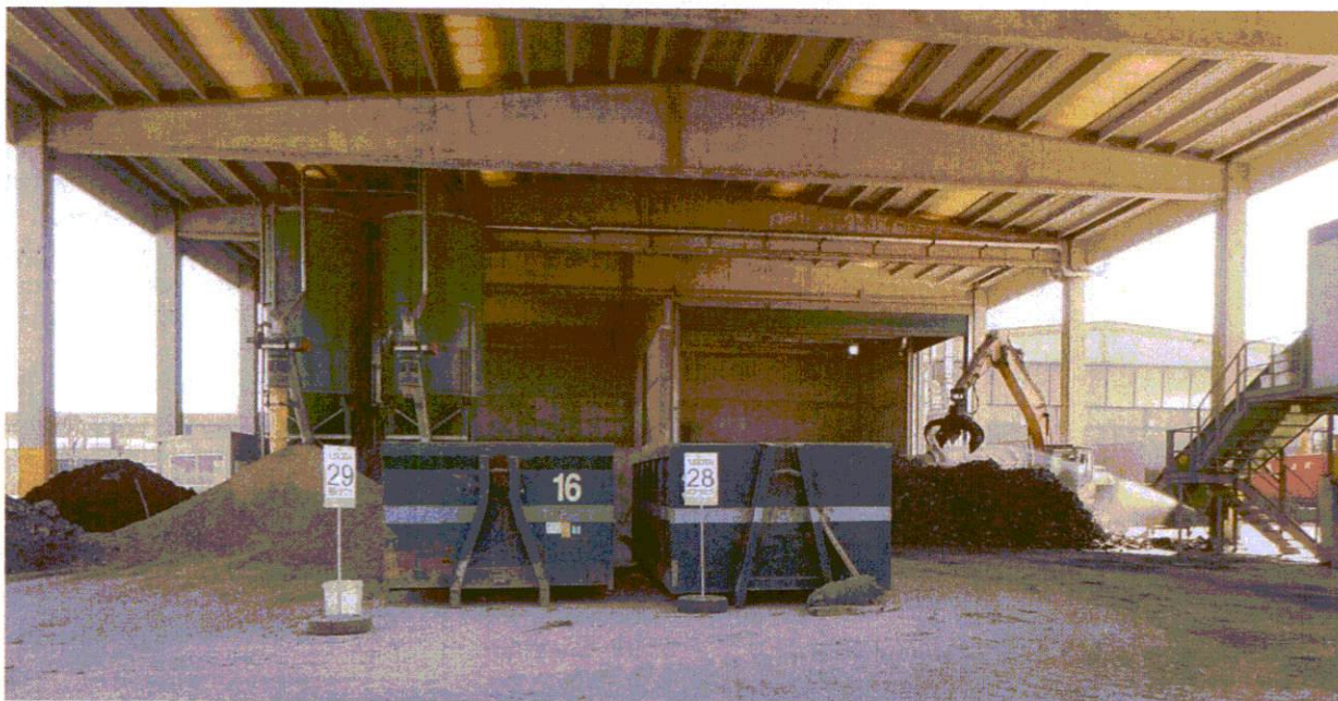
Figura 5-4 – Interno capannone AS5
