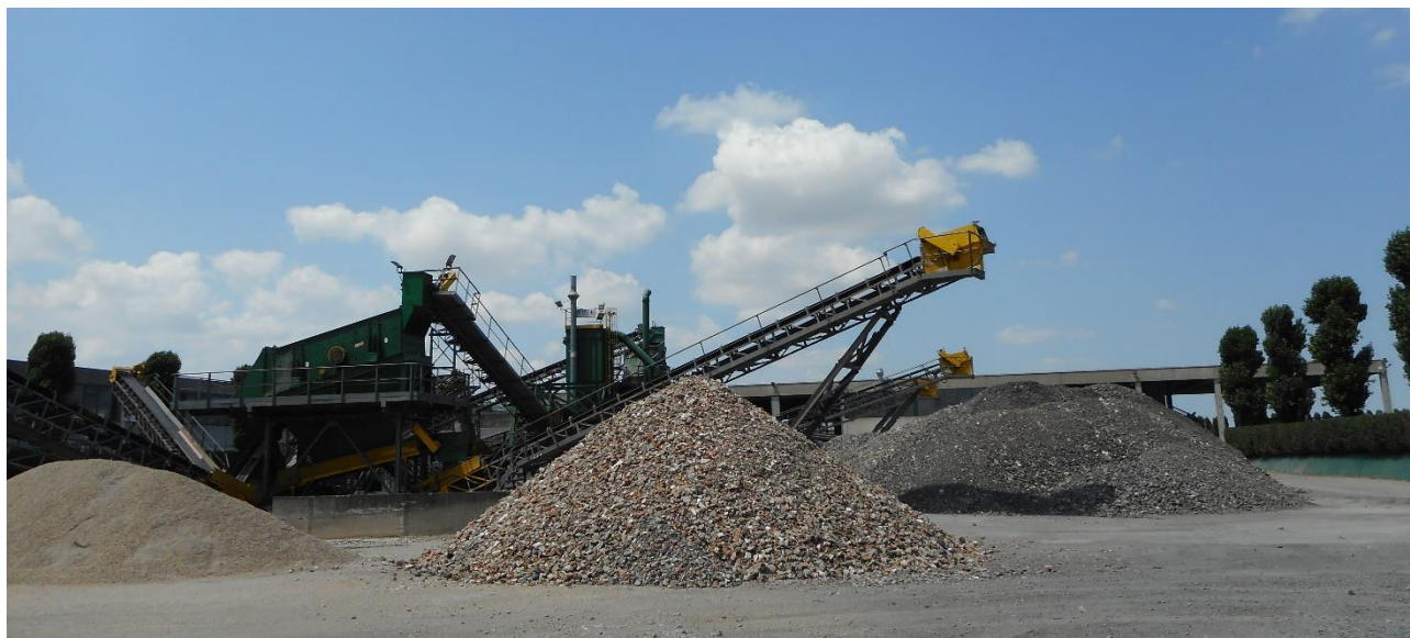
Figura 5-1 – Impianto di trattamento
