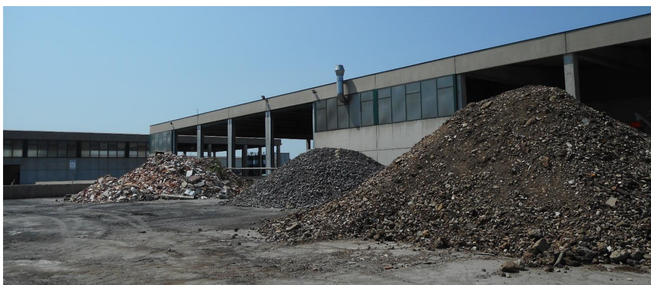
Figura 5-5 – Stoccaggio dei rifiuti
